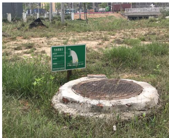
图片 4-6 污水排放口
