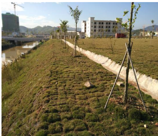
图片 9-14 边坡防护工程
