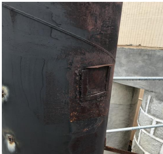
图片 9-8 锅炉废气监测孔
