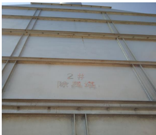
图片 4-13 除臭系统
