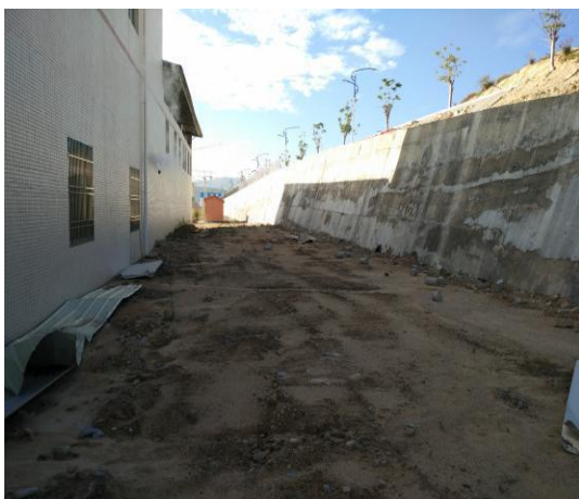
图片 9-15 边坡防护工程
